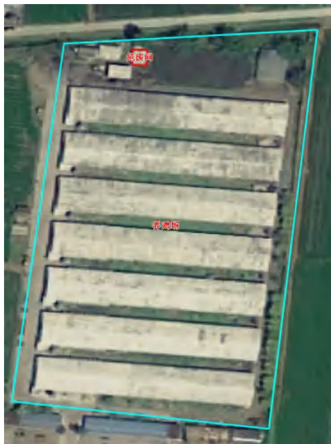
图 4.5-3 养鸡场危废间位置
