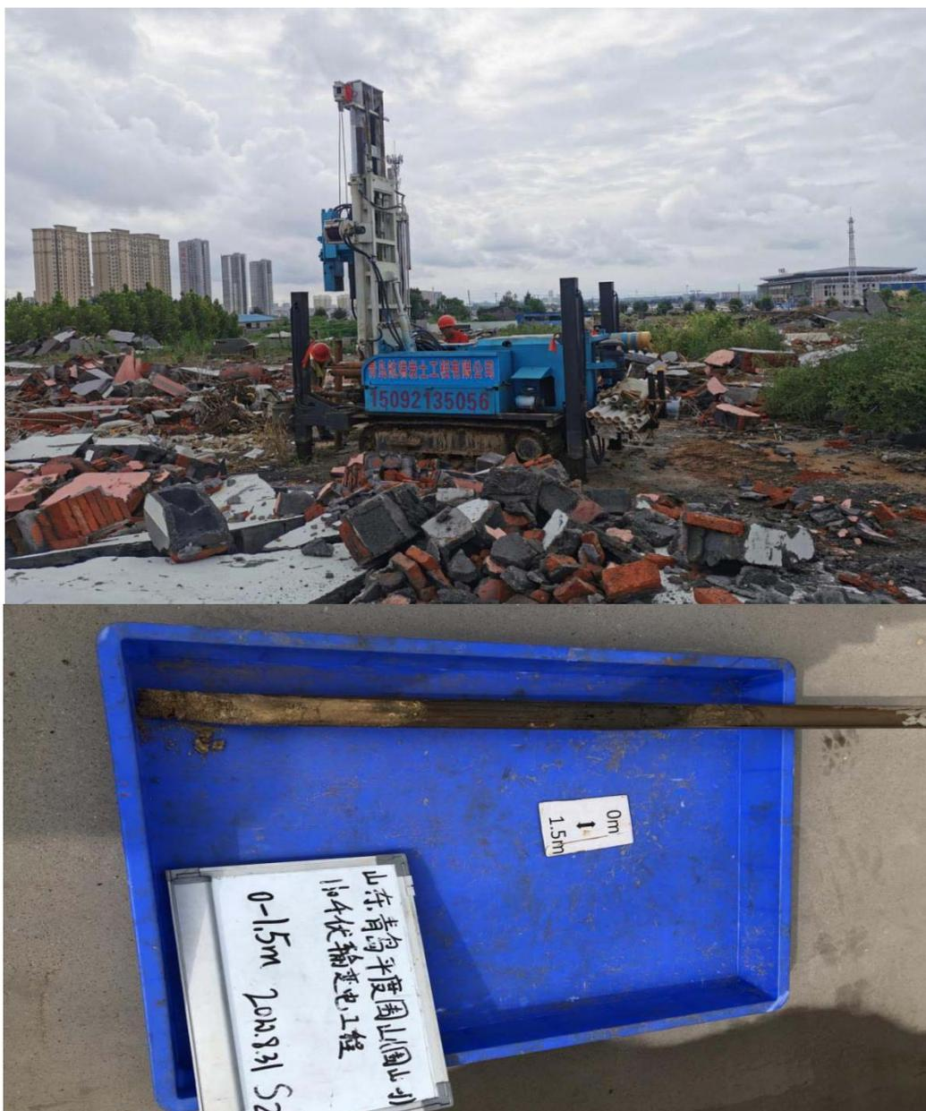
图 1-1 现场钻探及取样过程照片
